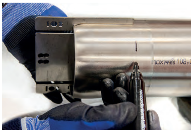
Bilde 29 – Merke innsetningsdybden med en markør Ø 76 mm – Ø 88 mm – Ø 108 mm
