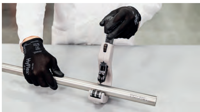
Bilde 26 – Tilkutting av rør
