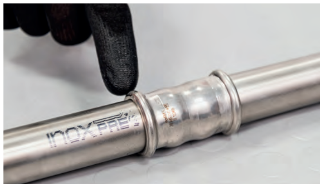
Bilde 38 – Kontroller presskoblingen
