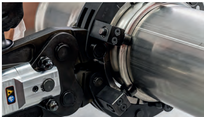
Bilde 40 – Montering av press, 2. fase
