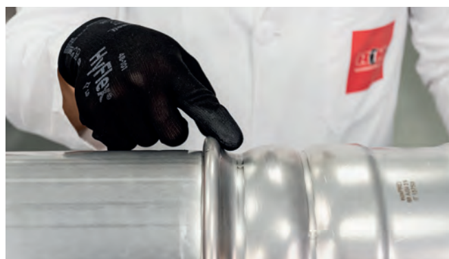
Bilde 41 – Visuell inspeksjon av Oversize-pressing
